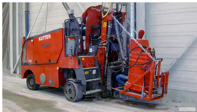
Abtrag des Estrichs mit einer Kleinfräse W50 DC mit integrierter Staubabsaugung.
