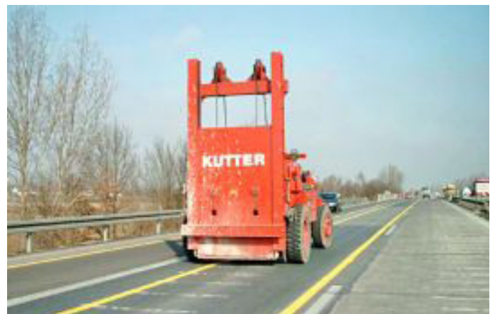
Zertrümmern einer Autobahn in einem definierten Schlagabstand von 40 cm.
