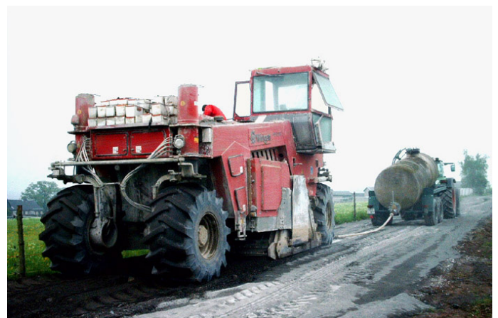
Bodenverfestigung mit dem WR 2500.
