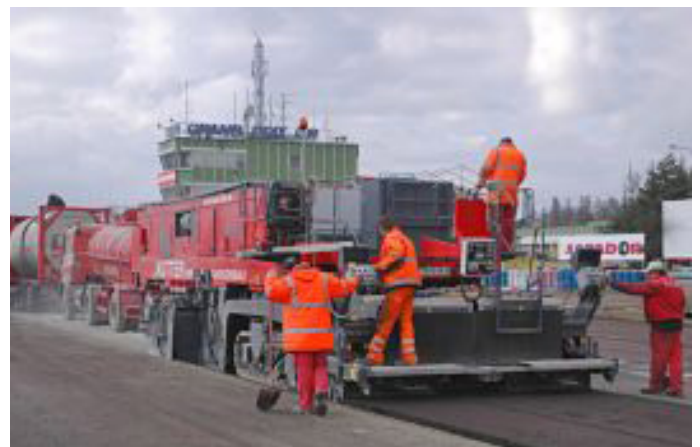
Die Einbaubohle am Mixpaver verdichtet den Baustoff vor und sorgt für die Profilierung sowie die korrekte Lage.
