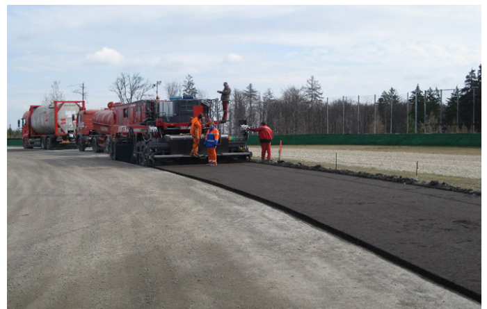
Am Steuerpult der Kaltmischanlage KMA 200 können alle Prozessparameter justiert werden.
