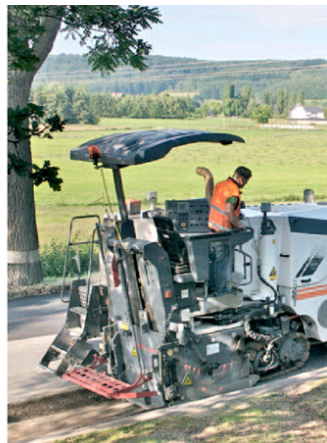
Prinzipische der Arbeitsweise von Kleinfräsen: Fräsrolle hinten rechts und Höhensteuerung über die Fahrwerke.
