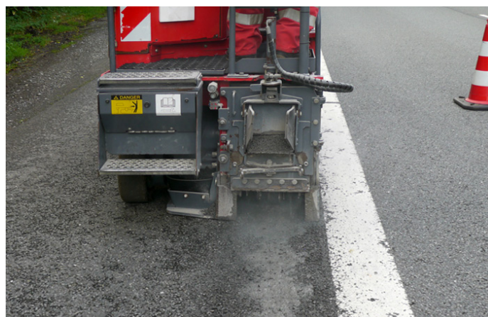
Herstellen von Rumble Strips.
