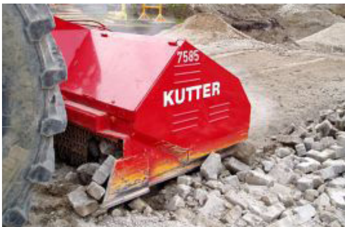
Aufbereiten von Gleisschotter einer stillgelegten Bahntrasse für einen Radweg.
