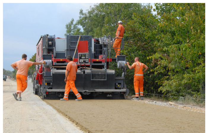
Kaltrecycling der Fahrbahndecke auf der A44 im Baumischverfahren mit dem Mixpaver.
