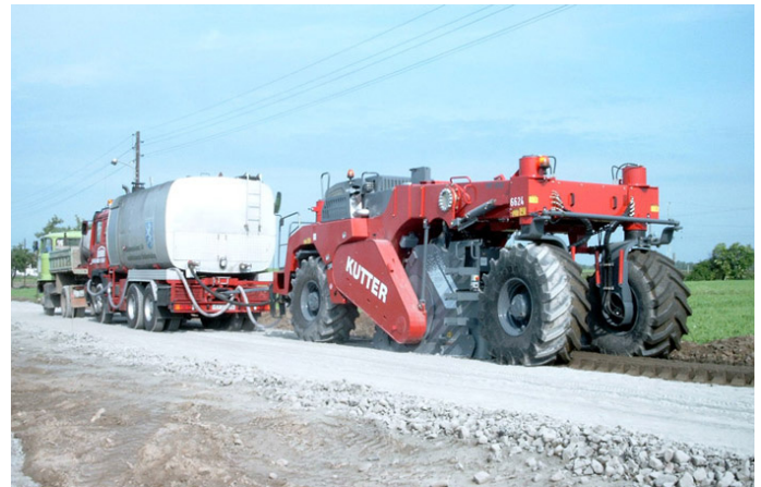
Neben Zement wird auch Bitumen zur Bindung der oberen Tragschicht verwendet.
