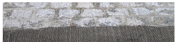
Angleichung eines Kopfsteinpflasters an den bestehenden Asphaltbelag mit Feinfräsrollen.
