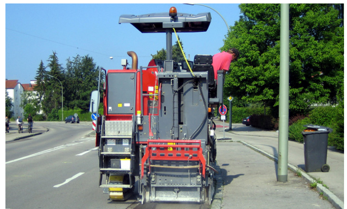
Beseitigung von Verdrückungen am Fahrbahnrand mit einer Feinfräse.
