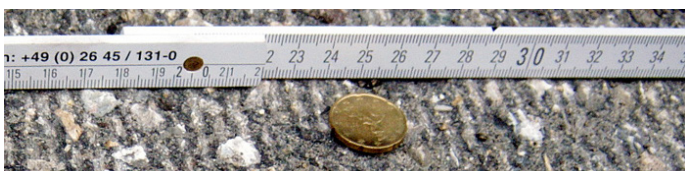
Gefräste Asphaltfläche, gefräst mit einer Feinfräse mit 6 mm Linienabstand.
