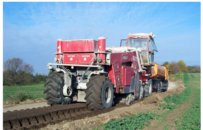
Bodenverfestigung mit dem WR 2500.
